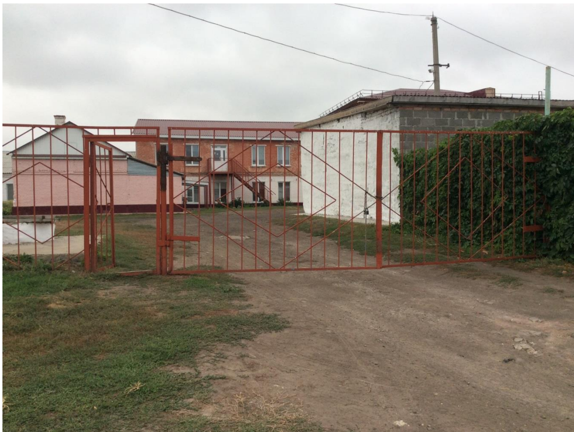
2. Въезд на территорию объекта с улицы Набережная
