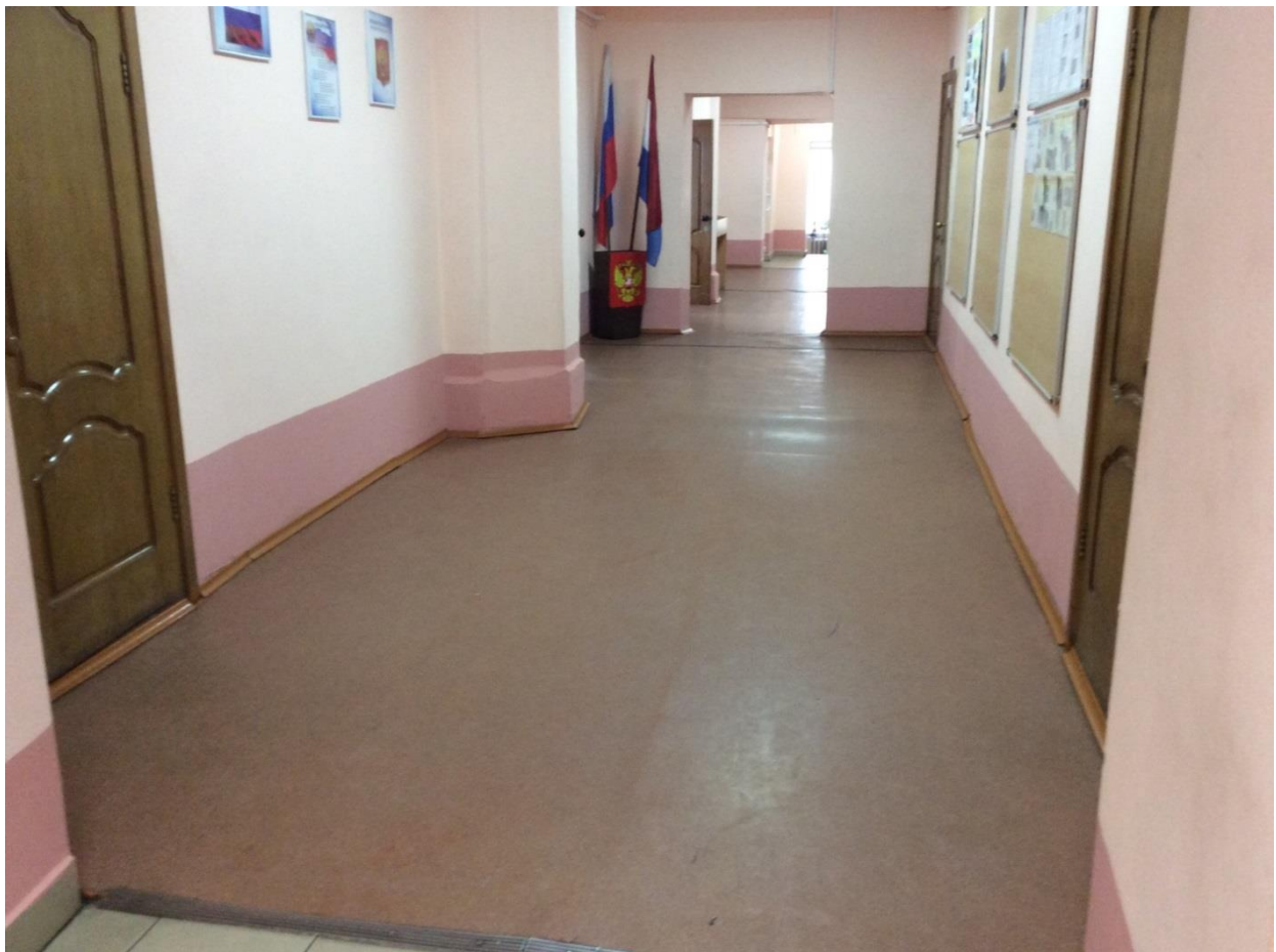
11. Коридор здания учебных классов 1 этажа правая сторона
