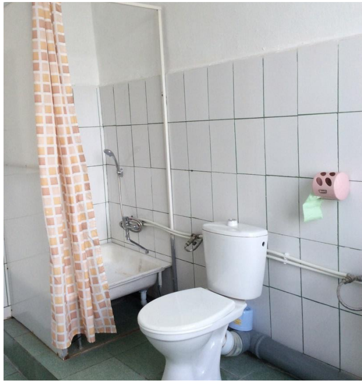
28. Санузел пристроя спален, душевая кабина
