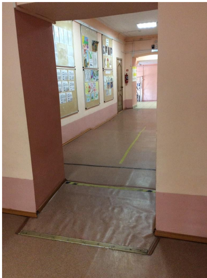
22. Пандус коридора здания учебных классов 1 этажа правая сторона
