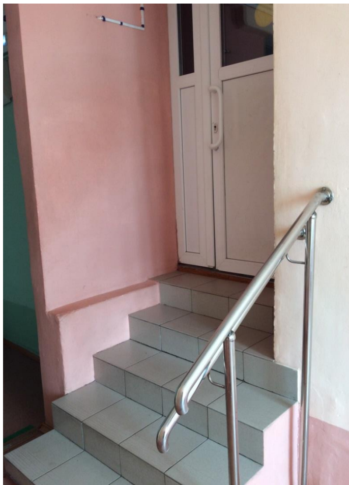
21. Перепад высот коридора здания учебных классов 2 этажа левая сторона
