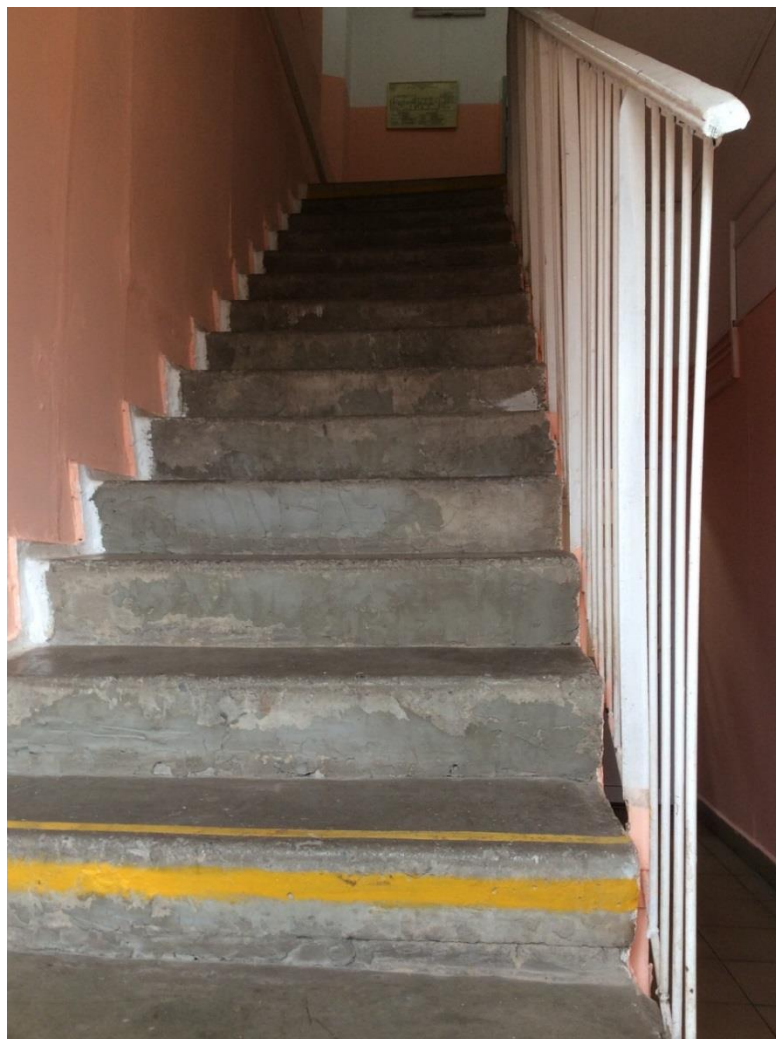
18. Лестница №2 межэтажная здания учебных классов
